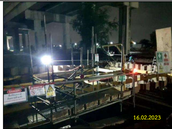
ข) อุปกรณ์ป้องกันการตกหลุมบริเวณปากหลุมร่องขุด/บ่อรับ-บ่อส่ง และมีแสงสว่างอย่างเพียงพอ และไฟกระพริบในเวลากลางคืน
