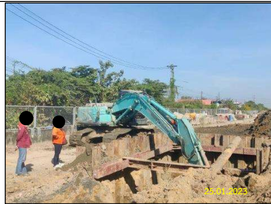
ก) การขุดด้วยเครื่องจักร ที่ไม่มีผู้ปฏิบัติงานในร่องขุด/บ่อรับ-บ่อส่ง
