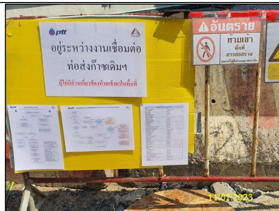
ข) กั้นพื้นที่ที่ทำการเชื่อมท่อ พร้อมทั้งติดป้ายเตือน
