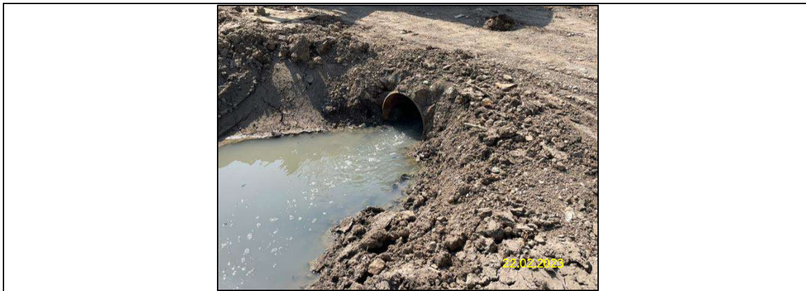
รูปที่ 2-18 การทำทางเบี่ยงเบนทิศทางการไหลของน้ำชั่วคราว
