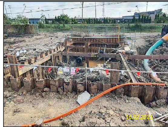
ข) อุปกรณ์ป้องกันการตกหลุมบริเวณปากหลุมร่องขุด/บ่อรับ-บ่อส่ง และมีแสงสว่างอย่างเพียงพอ และไฟกระพริบในเวลากลางคืน
