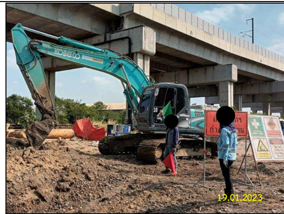
ก) การขุดด้วยเครื่องจักร ที่ไม่มีผู้ปฏิบัติงานในร่องขุด/บ่อรับ-บ่อส่ง
